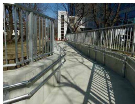
E 新船場西公園 エレベーターと階段、公園横の道路へはスロープでつながっている
